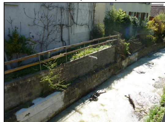
Abb. 17: Zustand Ufermauer (Bruchsteinmauer)
